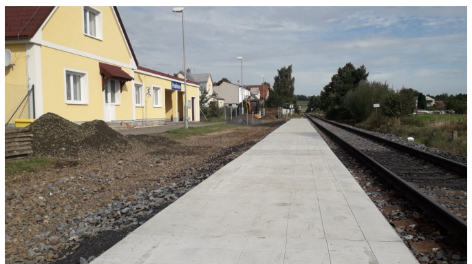
Foto: rekonstrukce železniční zastávky v Postřekově 08/2020
